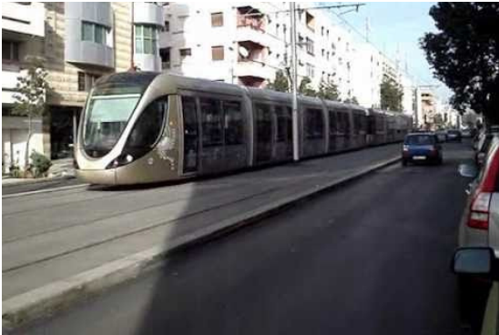
La ligne du tramway a transformé l'avenue de France, Agdal, Rabat
