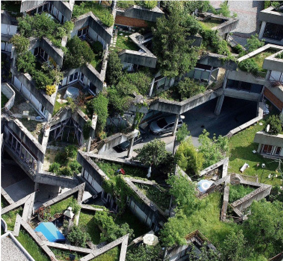
Opération « Les étoiles » à Givors – Jean Renaudie, architecte, 1975-1981, Projet à système pyramidal au niveau de l'îlot. L'îlot devient un conglomérat pyramidal intégrant des commerces, des ateliers et des circulations piétonnes. Les logements aux formes complexes disposent tous de nombreuses terrasses plantées. Le foisonnement végétal, qui contraste avec le béton brut des parois, participe à l'image de l'architecture.
